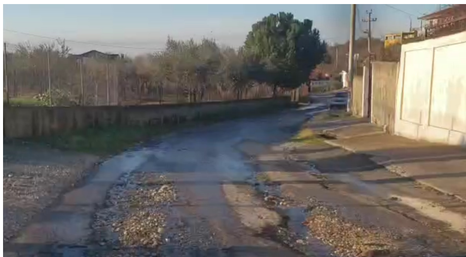
Figure 10 Gjendja ekzistuese nga km2 +840m
