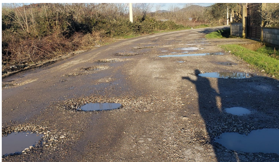
Figure 6 Gjendja ekzistuese nga km2 +320m
