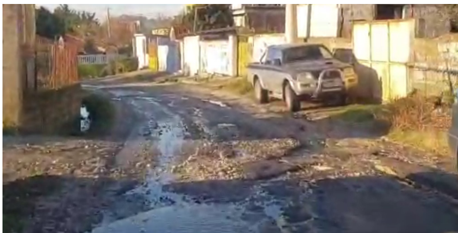
Figure 9 Gjendja ekzistuese nga km2 +740m
