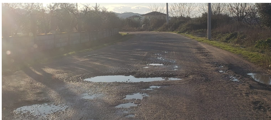
Figure 7 Gjendja ekzistuese nga km2 +380m
