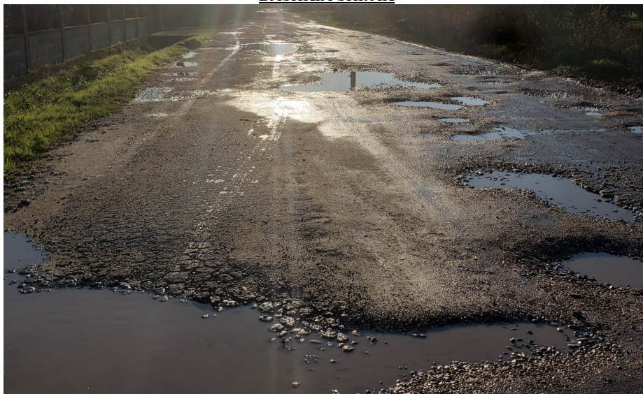
Figure 8 Gjendja ekzistuese nga km2 +540m
