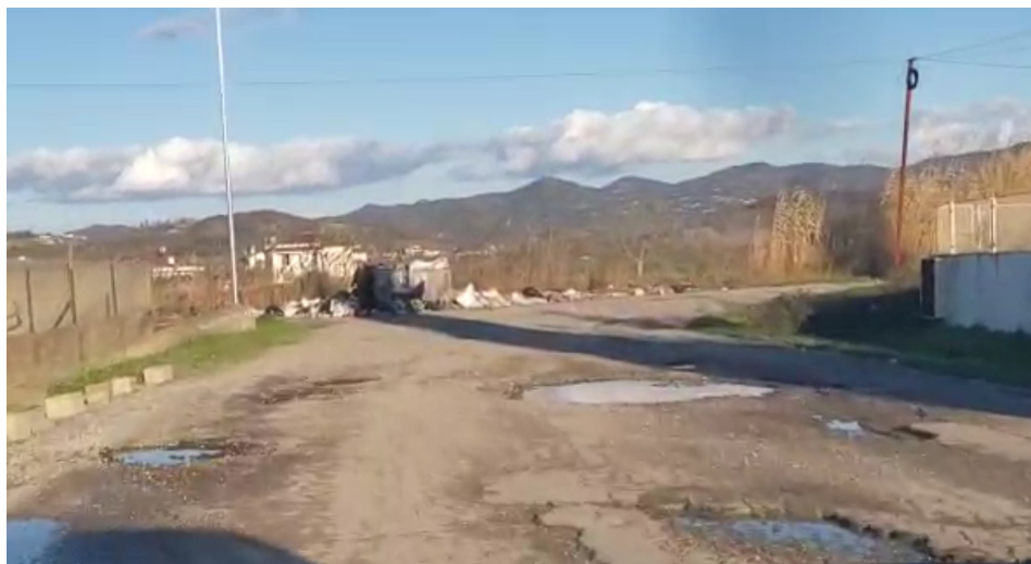
Figure 3 Gjendja ekzistuese nga km0 +940m
