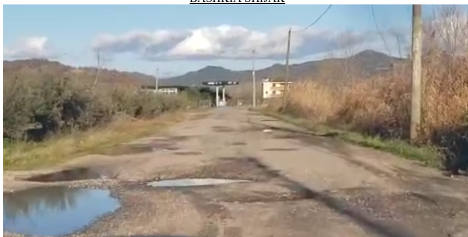
Figure 5 Gjendja ekzistuese nga km1 +660m
