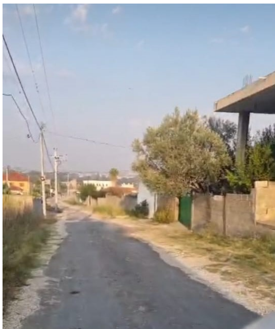
Figure 2 Gjendja ekzistuese nga km0 +340m
