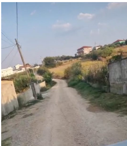
Figure 4 Gjendja ekzistuese nga km0 +340m deri km0+880m
