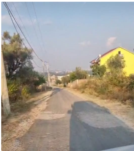
Figure 1 Gjendja ekzistuese nga km0 +340m
