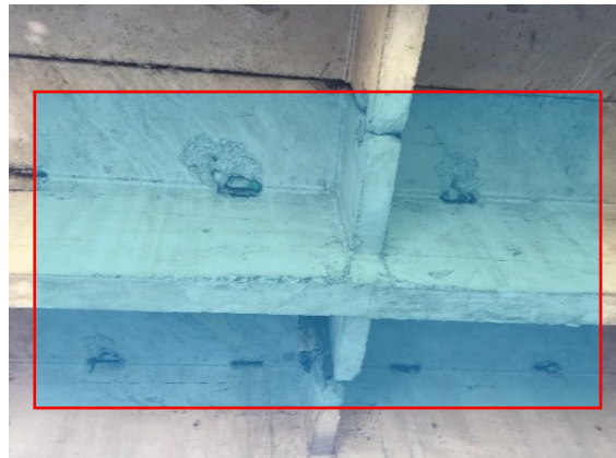
Ndërrhyrjet gjatë viteve (Lidhja e trarëve ekzistues me soletën e re 15cm)
