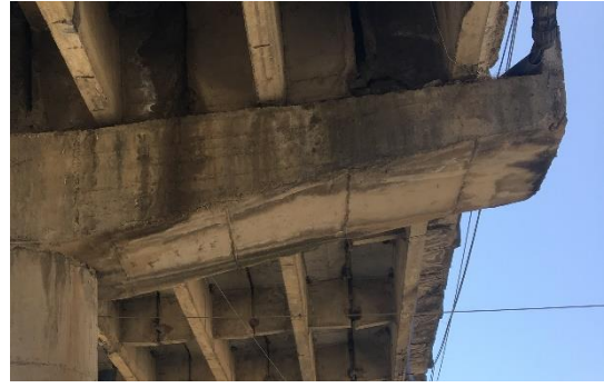
Ekspozimi i armaturës ekzistuese në jastëkët b/a
